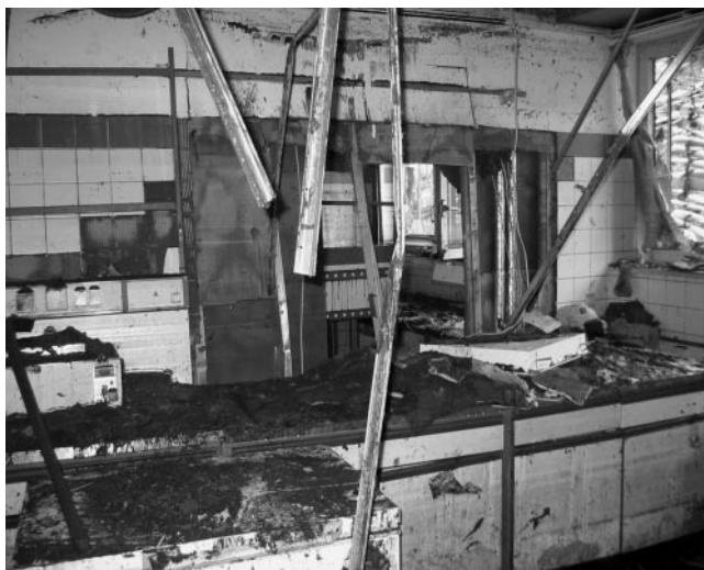
Bild 3: Schäden im Keller nach dem Hochwasser (KH Freital)
