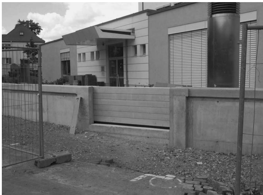
Bild 5: Hochwasserschutzwand mit mobilem Dammbalkenverschluss
