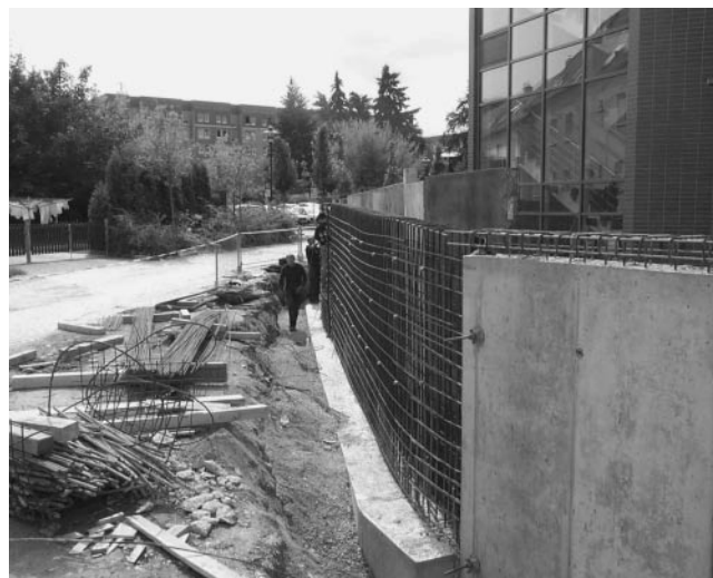
Bild 4: Hochwasserschutzwand auf Bohrpfehlwand im Bau
