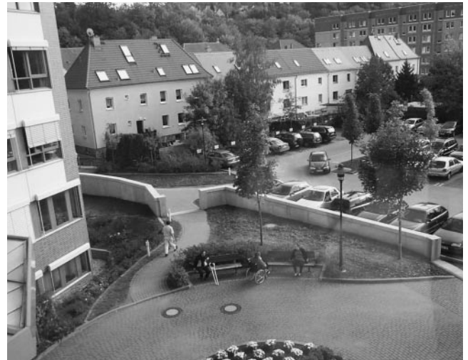
Bild 8: Blick auf den Eingangsbereich mit Hochwasserschutz
